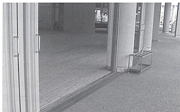
・段差のない体育館の出入口の事例
