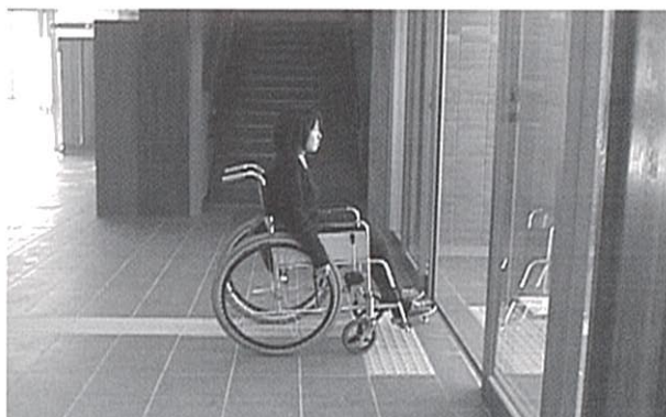
・自動引き分け戸（島田土木事務所）
