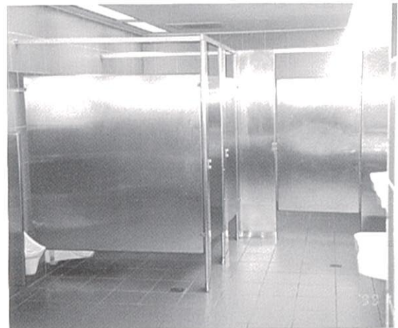
・米国の公園のトイレブースの事例 間仕切り壁と床までの開口高さの考え方は、日本と大きく相違しています
