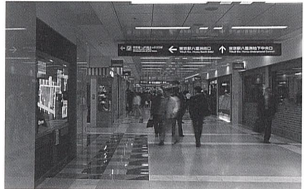
・取付下端 2.4 mの例
