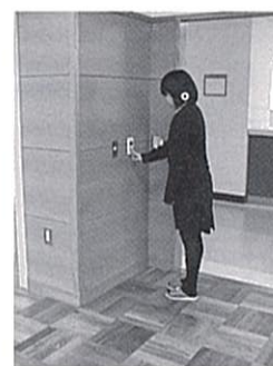
・床からの高さ100cm程のスイッチの事例 (島田土木事務所)
