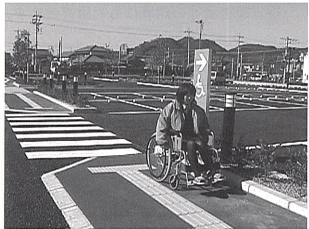
・透水性舗装など滑りにくい材料を使用した事例 (島田土木事務所)
