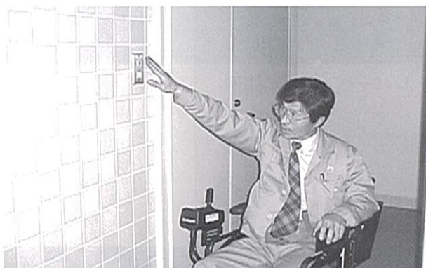
・床からの高さ130cm程のスイッチの事例
