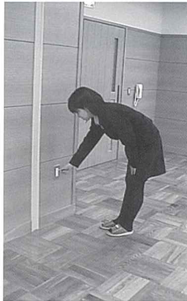
・コンセントの高さ約40cm程の事例 (島田土木事務所)
