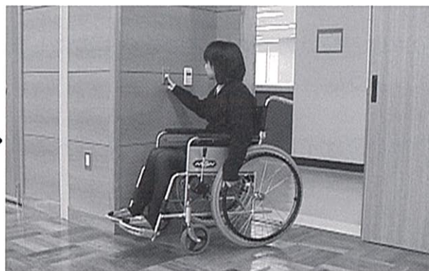
・床からの高さ100cm程のスイッチの事例 (島田土木事務所)
