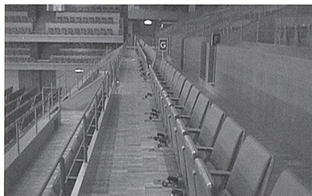
・取り外しが可能な車いす対応座席の事例 (静岡県グランシップ)
