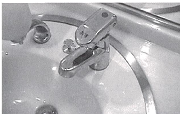
・プッシュレバー水栓（自動停止型）の事例
