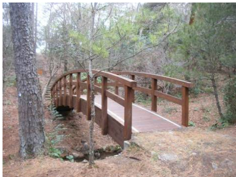
木橋（浜松市浜北区） 木製の自然ふれあい施設
