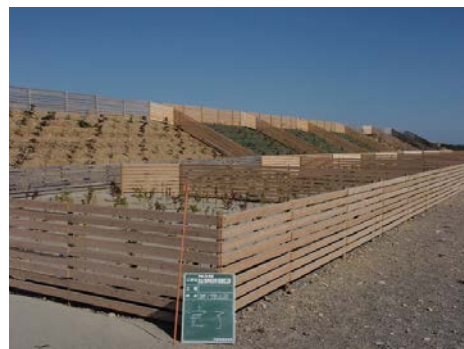
木柵工（浜松市南区） 製材品を利用した防潮堤整備事業
