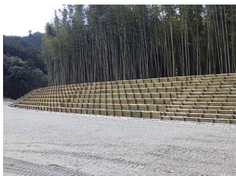
木製護岸工（浜松市天竜区） 円柱加工丸太を利用した河川事業
