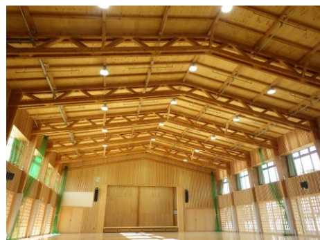
静岡県立西部特別支援学校体育館（浜松市北区） 在来工法用いてコスト縮減を図った教育施設
