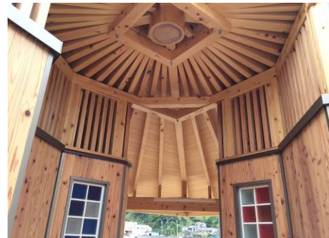
田子みなと公園トイレ（賀茂郡西伊豆町） 公園施設
