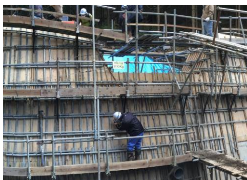
仮設工（富士市） 合板型枠を利用した治山事業
