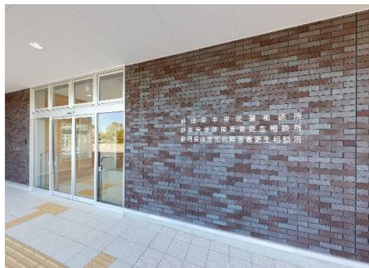
外観（ピロティ）
