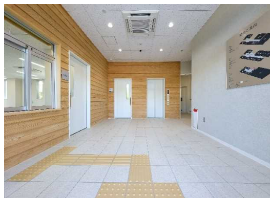
内観（玄関ホール）
