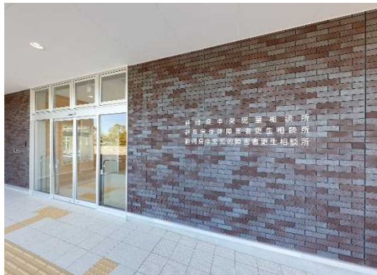
外観（ピロティ）
