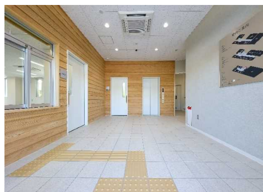
内観（県産桧下見板張り）
