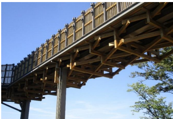
回廊下部の木組み
