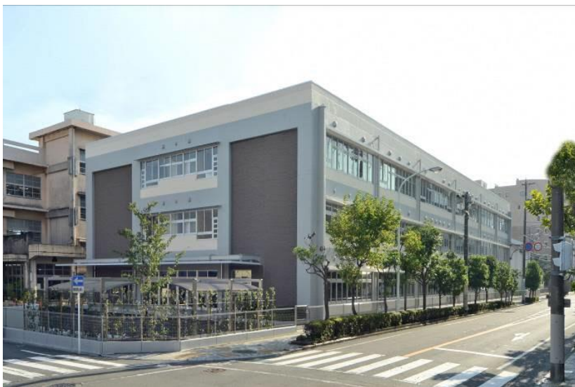
校舎外観（北東側）
