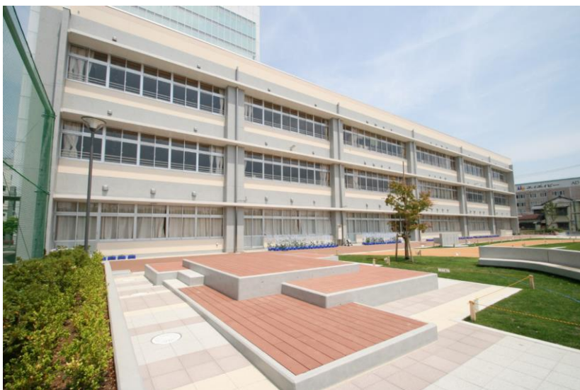
校舎外観（南西側）
