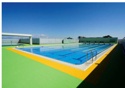
校舎屋上プール
