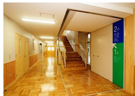
腰壁の木質化
