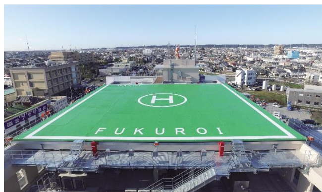
屋上ヘリポート
