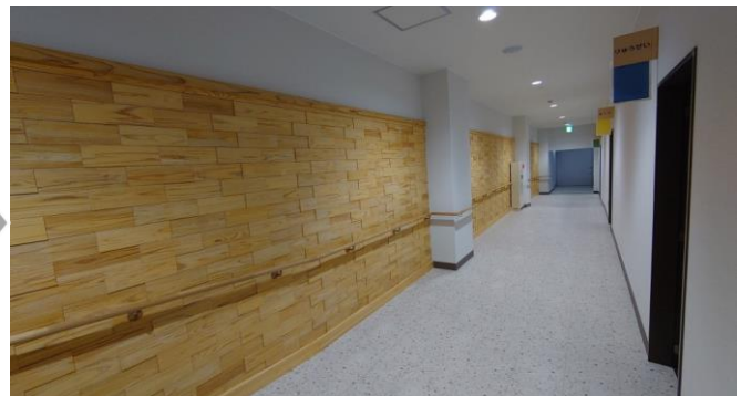
内観 (改修後:廊下)
