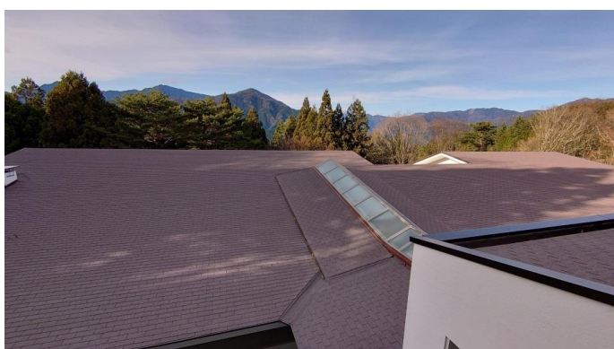
外観（改修後：屋根）
