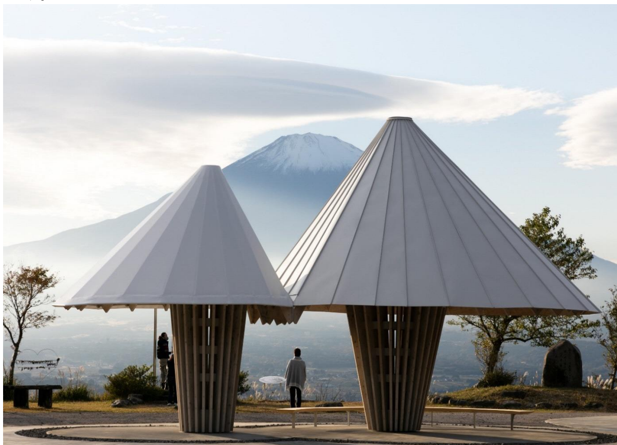
母屋棟 外観（東面）
