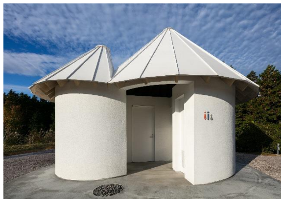
トイレ棟 外観
