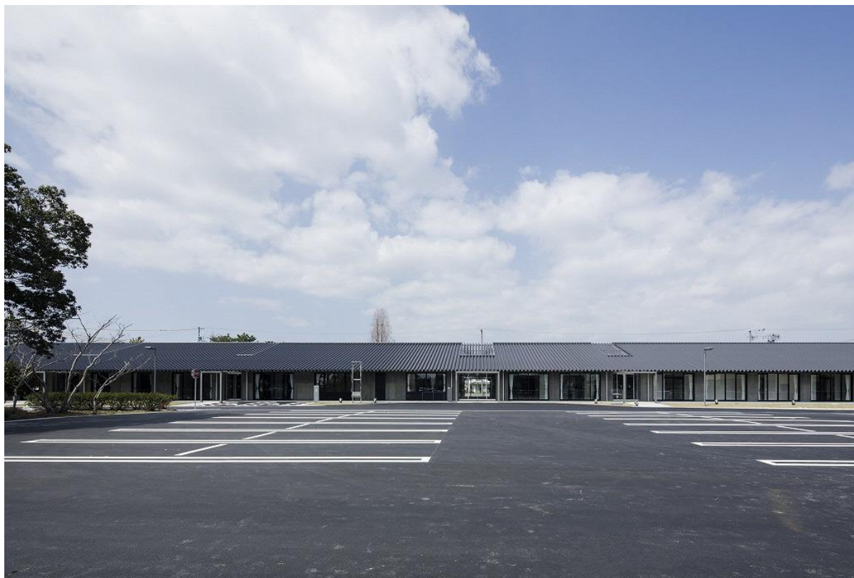
南側駐車場から見る（東西方向に約100mの平屋）
