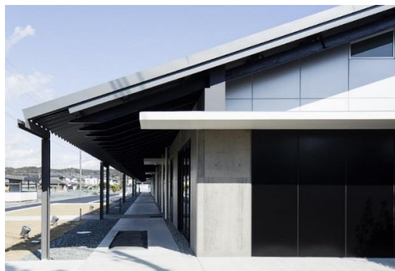
北側軒先を見る
