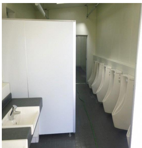
内観（公衆トイレ）
