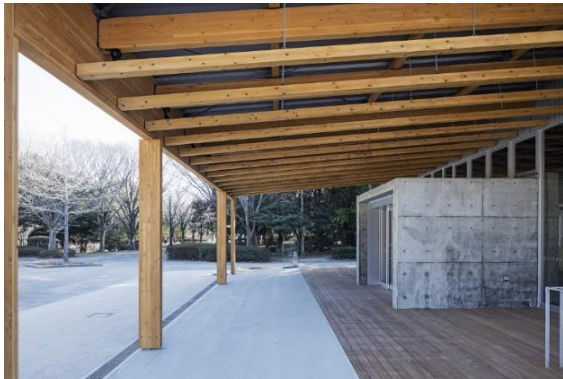
エントランスデッキを見る
