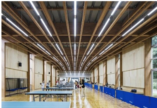
アリーナを見る（門型フレームが連続する）
