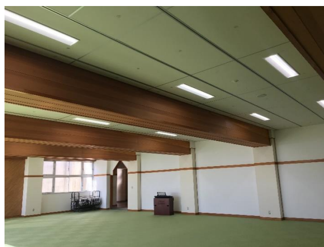
4階 多目的ホール(改修後)
